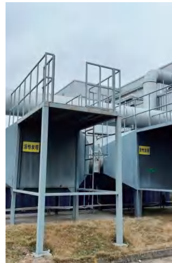
GC Suzhou的双碳塔废气处理装置
