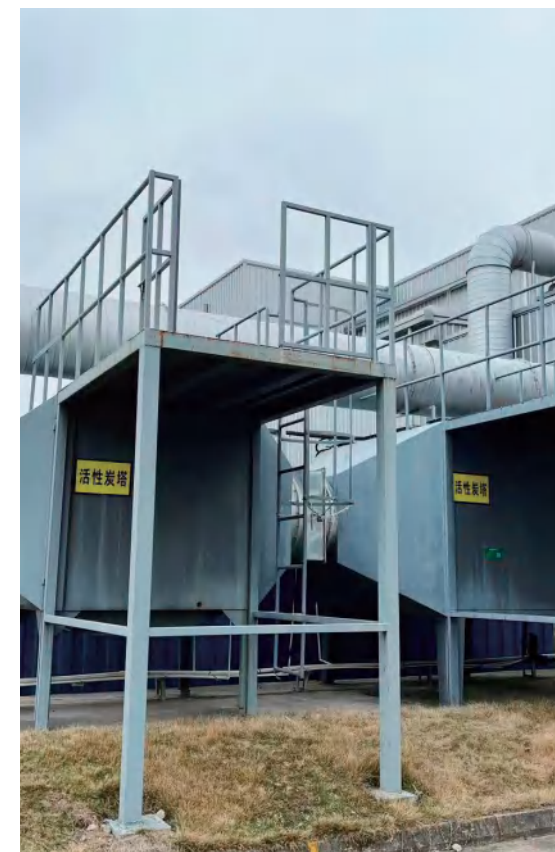
GC Suzhou的双碳塔废气处理装置
